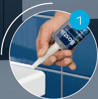
Aplicați izolantul Bostik Perfect Seal
